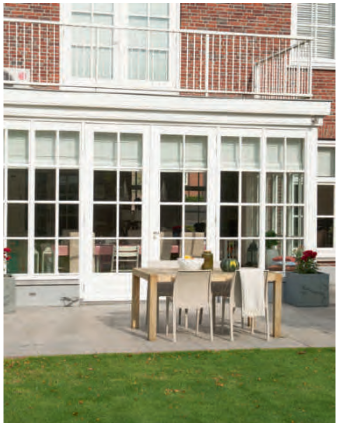
De roedeverdeling van de deuren is exact afgestemd op die van de ramen
