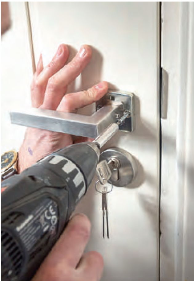
De nieuwe deur wordt vakkundig gemonteerd inclusief beslag
