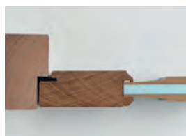
Doorsnede geïsoleerde deur 54 mm
